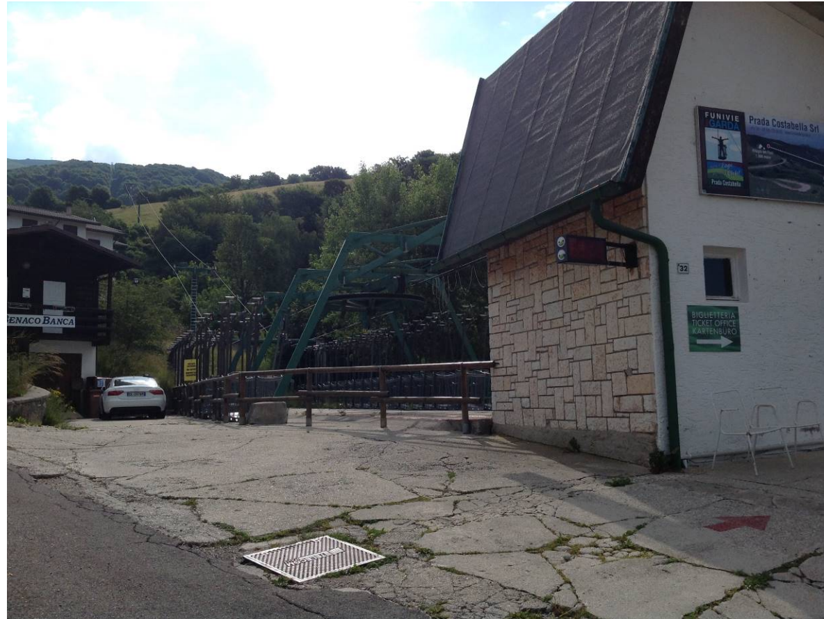
Fotografia allo stato attuale – STAZIONE DI VALLE BIDONVIA
