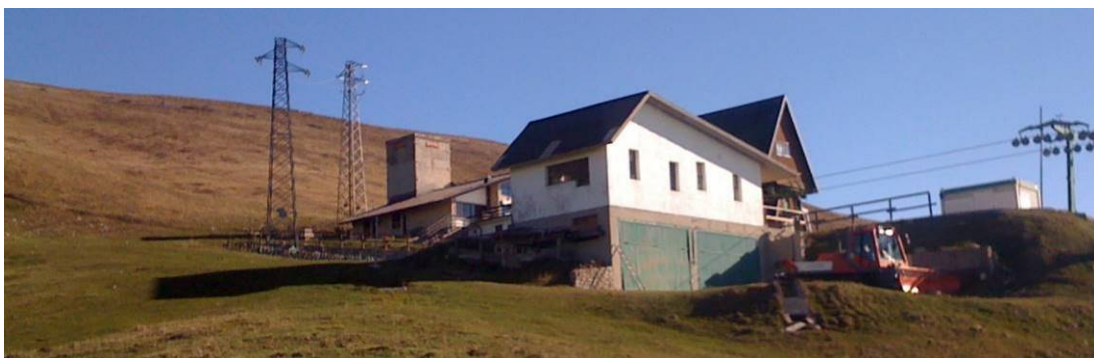
Edificio adibito a deposito, magazzino e ricovero battipista.
