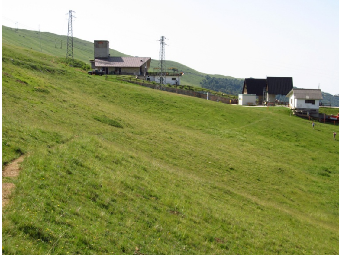
Fotografia allo stato attuale vista laterale- STAZIONE INTERMEDIA
