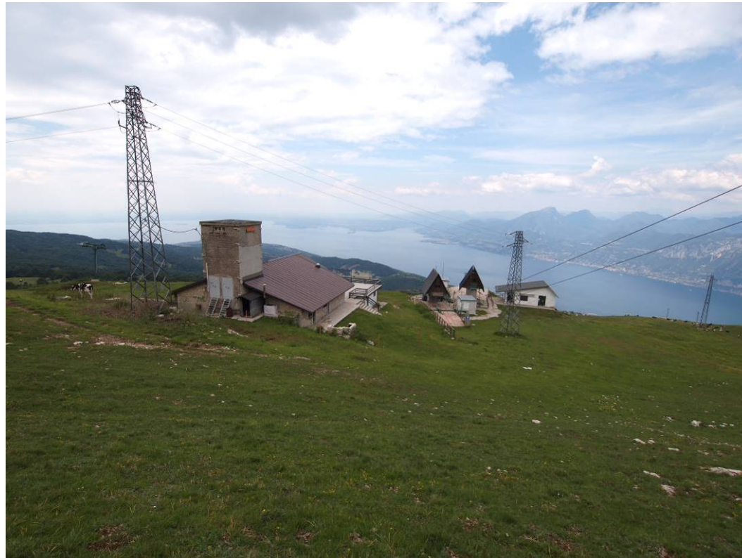
Fotografia allo stato attuale – STAZIONE INTERMEDIA
